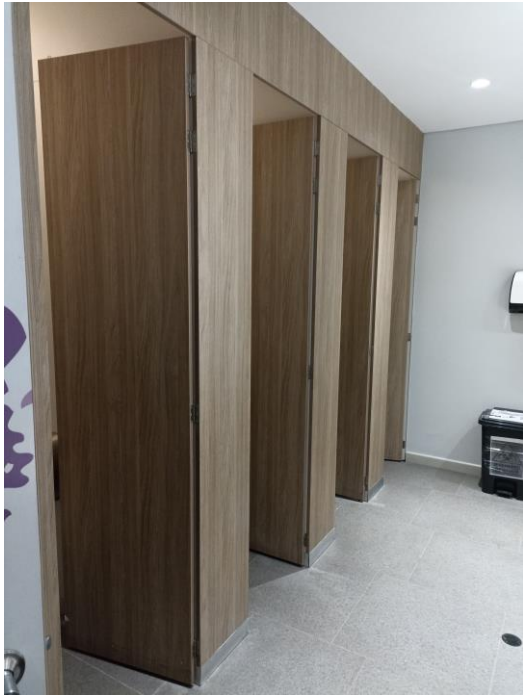
Imagen Nro. 6 Batería de Baños - Piso 16 – 17 y 18
